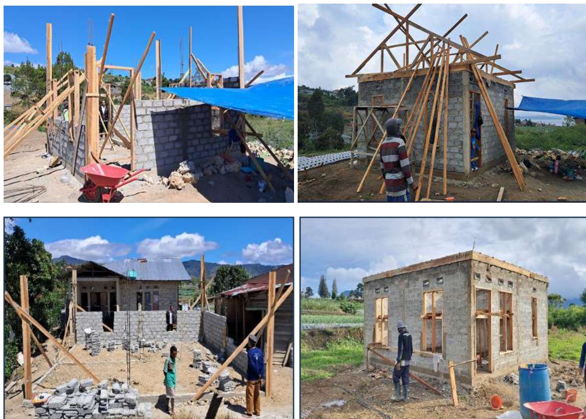
Foto Dokumentasi pekerjaan konstruksi perbaikan rumah tidak layak huni
