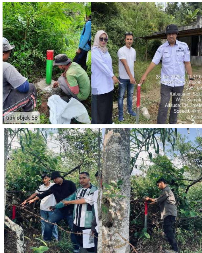
Foto Dokumentasi Pemasangan Patok Batas Tanah dan Pengukuran/Penelitian Tanah
